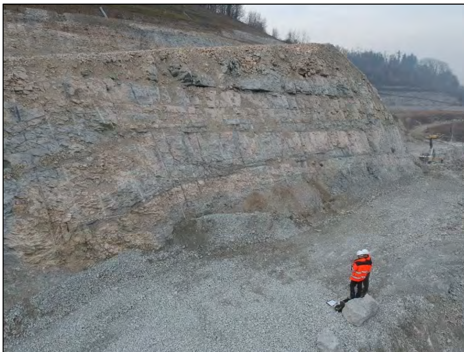
Figura 4.3 – Fronte lato ovest (RGS-05-17).
