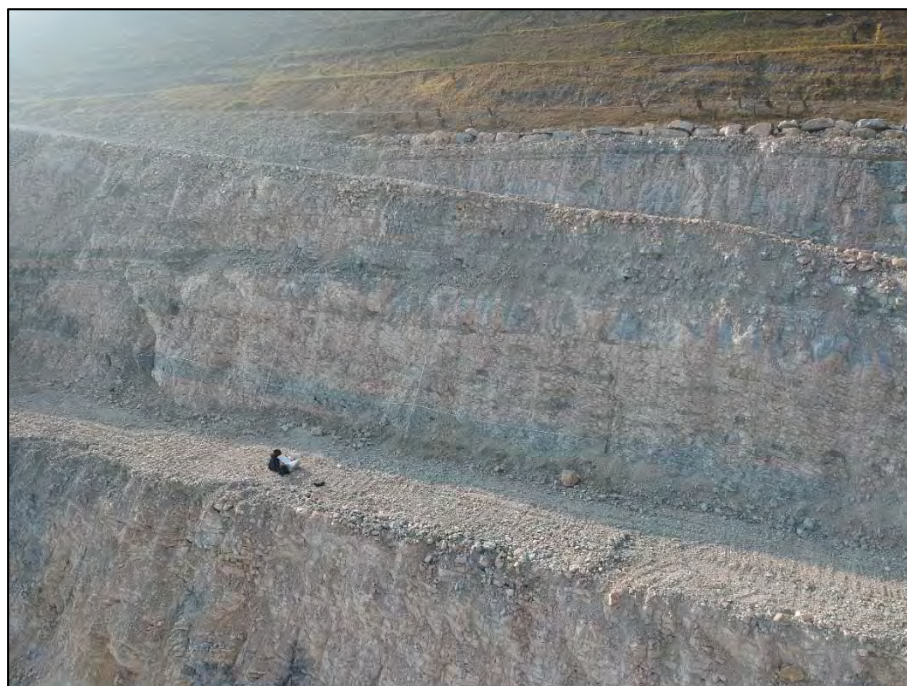
Figura 4.2 – Fronte lato ovest (RGS-04-17).
